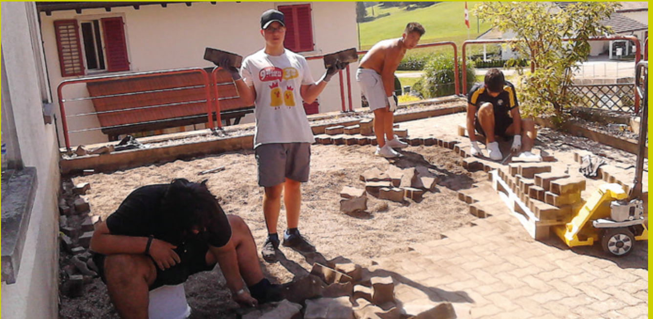
Sanierung des Vorplatzes des neuen Werkhauses
